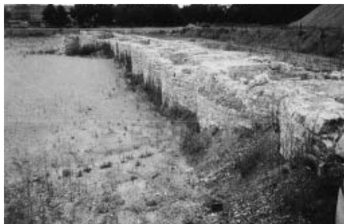
Esplanade 2, Fundamentreste des Kavaliers Dallwigk
