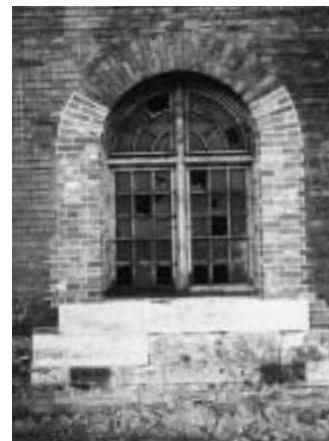
Ehem. Geschützgießerei, Fenster
