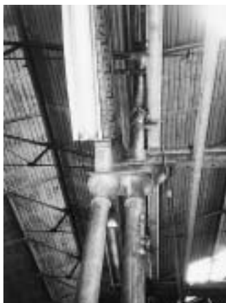
Ehem. Geschützgießerei, Fabrikhalle, Konstruktionsdetail
